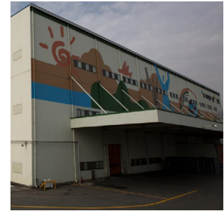
대전2공장 (PET병, PET프리폼) 대전광역시 대덕구 신일서로17번길 93
